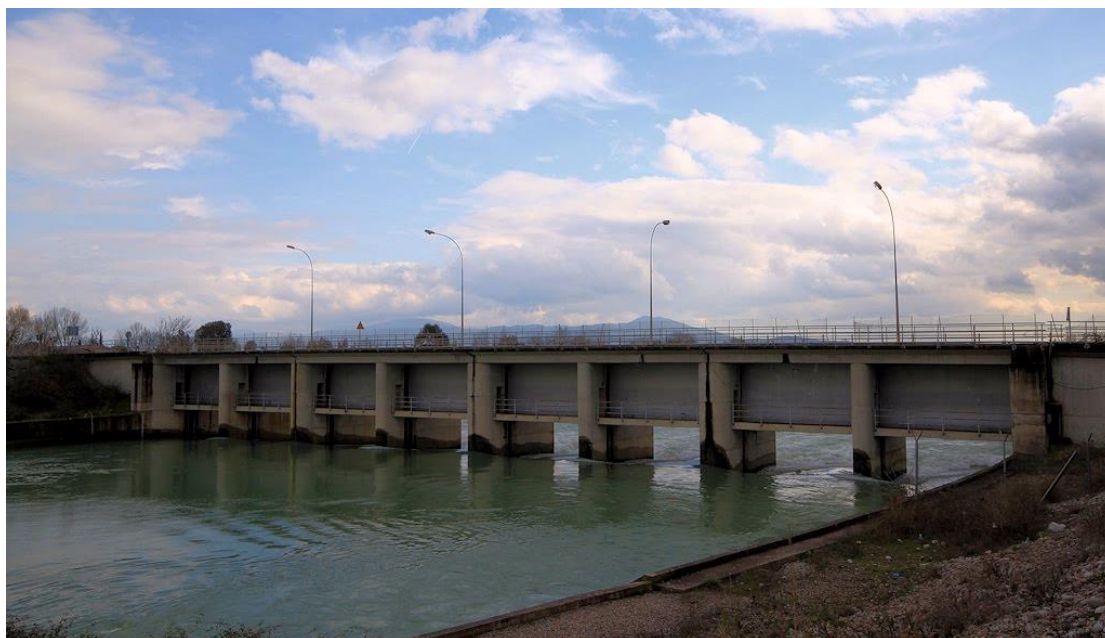
Εικόνα 23, Η τεχνητή κοίτη του Αχελώου και η γέφυρα της ΔΕΗ στα όρια Γουριώτισσας-Καλυβίων 721
