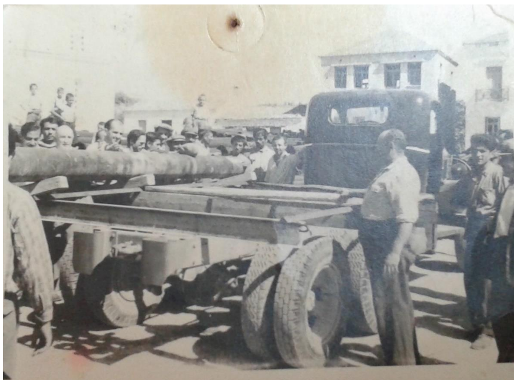
Εικόνα 65, Έργο ύδρευσης και άρδευσης Ξηρομέρου, 1952 1203
