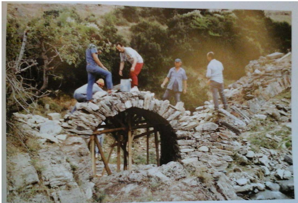
Το 1992 αρχίζει με εθελοντική αποκλειστικά εργασία μελών και φίλων του συλλόγου η επιδιόρθωση της τοξωτής γέφυρας στο Μαρούφι, της οποίας το μικρό τόξο είχε ολόκληρα καταρρεύσει. Οι εργασίες θα συνεχιστούν και την επόμενη χρονιά.
