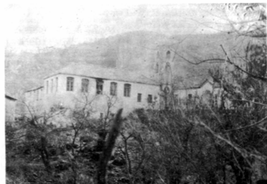
Εικόνα 24. Το σχολείο Κοσοβίτσας, κτίστηκε το 1872
