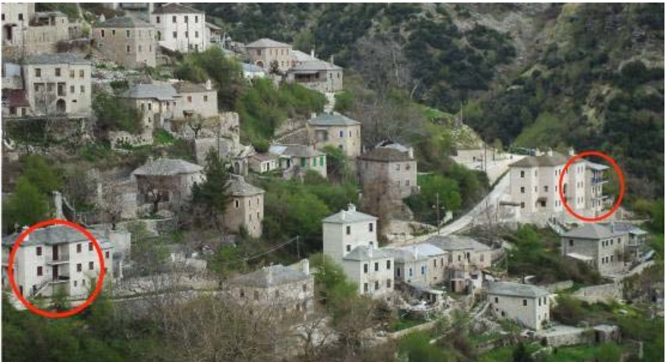
Εικ. 4.13. Σύγχρονα κτίρια με εξώστες. Τα κτίρια δεν εντάσσονται στην τοπική παράδοση αλλά ταυτόχρονα, εξαιτίας των υλικών κατασκευής τους κυρίως, μοιάζουν να «χάνονται» στο σύνολο (φωτογραφία: Προσωπικό αρχείο).
