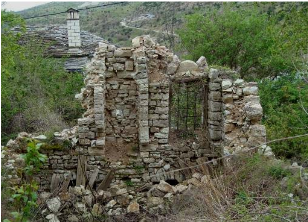
Εικ. 2.19. Ερείπιο σπιτιού στο Συρράκο. Στη μέση διακρίνεται το ίχνος του τζακιού με το μικρό άνοιγμα στο κάτω τμήμα του. Στο κάτω τμήμα του κτιρίου διακρίνεται η κατασκευή των καμπύλων ανοιγμάτων, του κάτω ορόφου, η οποία διαφέρει από αυτή των ανοιγμάτων του επάνω ορόφου, όπως φαίνεται στο δεξί παράθυρο που σώζεται. (φωτογραφία: Προσωπικό αρχείο)
