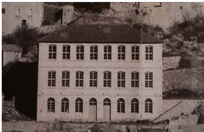
Εικ. 2.23. Το σχολείο (νότια όψη). (φωτογραφία: Συρράκο. Πέτρα – Μνήμη – Φως, Τόμος 1).
