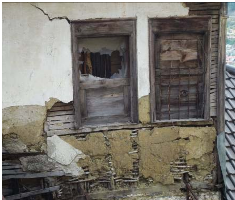
Εικ. 2.1. Εξωτερικός τοίχος ορόφου σπιτιού στο Μέτσοβο, στον οποίο διακρίνεται η κατασκευή του (μπαγδατί) (φωτογραφία: Προσωπικό αρχείο).
