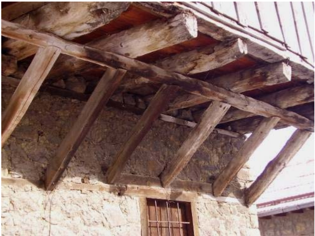
Εικ. 2.6. Λεπτομέρεια κατασκευής προεξοχής (κεπέγκι) στον όροφο. Η συγκεκριμένη κατασκευή είναι ξύλινη (σανίδες), χωρίς επίχρισμα (φωτογραφία: Προσωπικό αρχείο).
