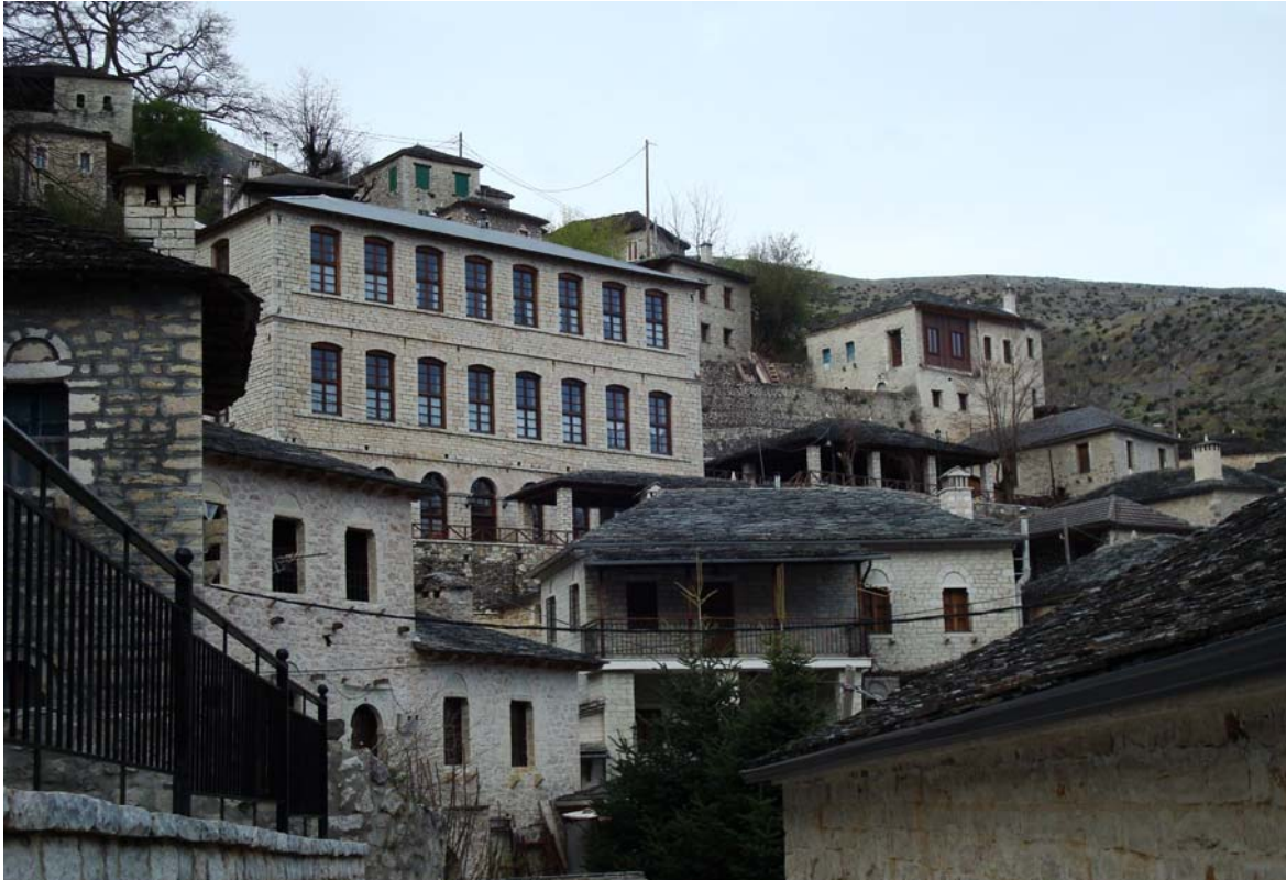
Εικ. 2.22. Το (πρώην) Δημοτικό Σχολείο του Συρράκου (ξενώνας σήμερα). Το κτίριο ξεχωρίζει για τον όγκο του αλλά και την επιμελημένη κατασκευή του. Κτίστηκε το 1929. Είναι τριώροφο με την είσοδό του στην πλαϊνή, στενή πλευρά (δυτικά), στο μεσαίο επίπεδο (α' όροφος), το οποίο λόγω της κλίσης του εδάφους είναι, στην πλευρά αυτή, ισόγειο. Είναι χαρακτηριστικά τα μεγαλύτερα σε μέγεθος ανοίγματα που σηματοδοτούν την λειτουργία του κτιρίου, η ιδιαίτερα προσεγγμένη κατασκευή των πρεκιών, σε όλους τους ορόφους και η συμμετρία στην οργάνωση των όψεων. Οι αίθουσες είναι τοποθετημένες όλες στη νότια πλευρά (όπου τα ανοίγματα). Η είσοδος βρίσκεται στην άκρη της στενής πλευράς και εσωτερικά οι αίθουσες εκτονώνονται σε φαρδύ διάδρομο. Οι πίσω πλευρές του ισογείου και του α' ορόφου δεν έχουν ανοίγματα και εφάπτονται στο έδαφος, λόγω της κλίσης του εδάφους. Το κτίριο ανακαινίσθηκε (μετά το 1980), για να στεγάσει ξενώνα και εσωτερικά έγιναν επιμέρους διαμορφώσεις για την κάλυψη των αναγκών του ξενώνα (φωτογραφία: Προσωπικό αρχείο).
