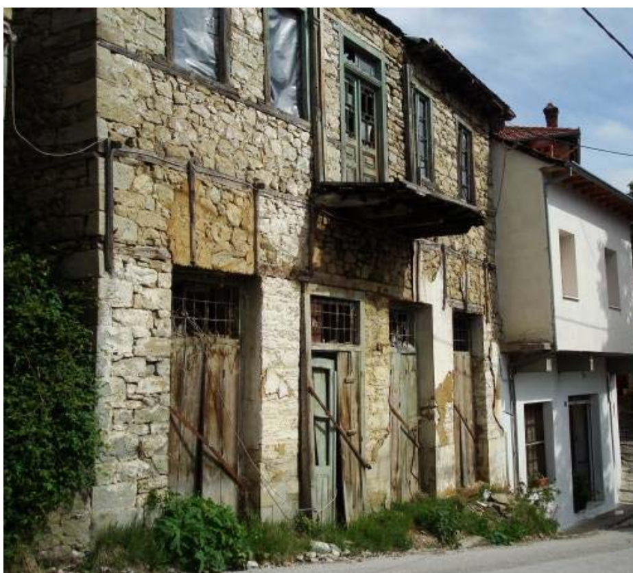
Εικ. 2.2. Μέτσοβο. Παραδοσιακό σπίτι, στο ισόγειο του οποίου στεγάζονταν μαγαζιά. Εκτιμάται, ότι στον όροφο ήταν η κατοικία του ιδιοκτήτη. Είναι εμφανής η διαφοροποίηση των ανοιγμάτων του ισόγειου, σε σχέση με τα αντίστοιχα, των κατοικιών του οικισμού. Το κτίριο βρίσκεται σε κεντρικό δρόμο, στην δυτική πλευρά του οικισμού και είναι, σήμερα, εγκαταλελειμμένο (φωτογραφία: Προσωπικό αρχείο).
