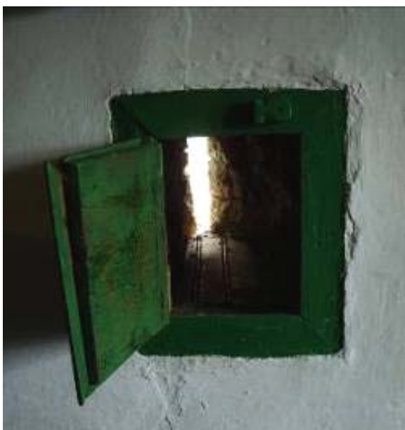
Εικ. 2.16. Εσωτερικό αρχοντικού Κ. Αυδίκου. Άνοιγμα στην εξωτερική τοιχοποιία: Πολεμίστρα. Στο εξωτερικό τμήμα το μέγεθός της είναι λίγο μεγαλύτερο από σχισμή ενώ εσωτερικά μεγαλώνει και κλείνεται με ξύλινο πορτάκι. (φωτογραφία: Προσωπικό αρχείο)
