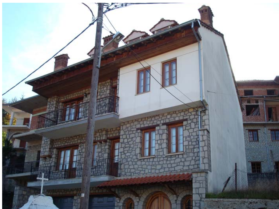
Εικ. 4.6. Χαρακτηριστική περίπτωση κτιρίου του οποίου η πλαϊνή πλευρά μένει αδιαμόρφωτη, λόγω γειτνίασης με διπλανό οικόπεδο ενώ στη στέγη έχουν κατασκευαστεί φεγγίτες, στοιχείο ξένο με την τοπική παράδοση (φωτογραφία: Προσωπικό αρχείο).
