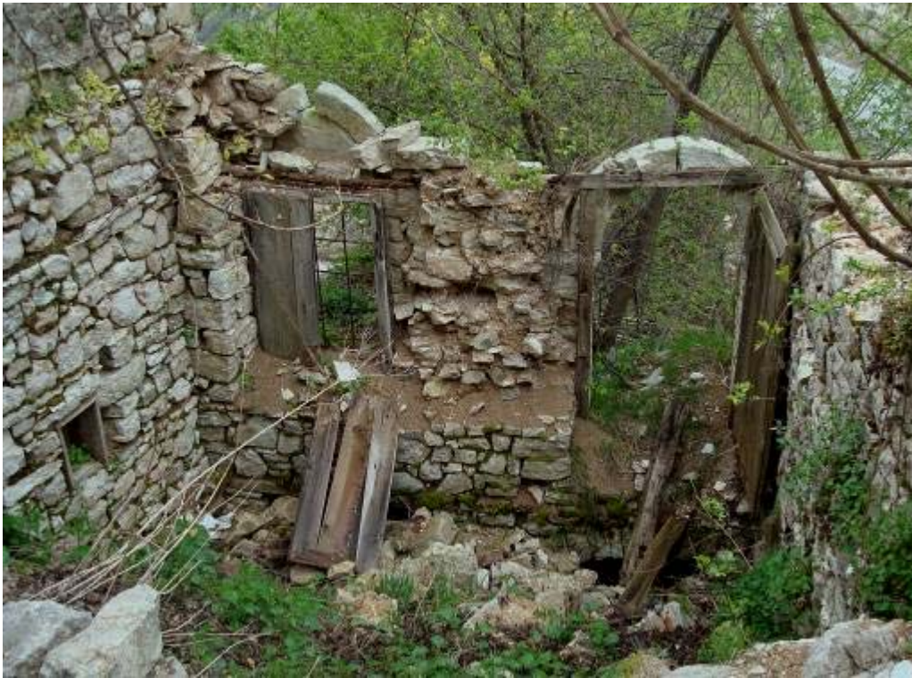
Εικ. 2.18. Ερείπιο σπιτιού στο Συρράκο. Φαίνεται η κατασκευή της καμπύλης απόληξης των ανοιγμάτων, από το εσωτερικό της κατοικίας. Το κούφωμα της πόρτας τοποθετείται έτσι ώστε να μην είναι εμφανές από την εξωτερική πλευρά. Στον αριστερό τοίχο διακρίνεται η χαρακτηριστική εσοχή – εντοιχισμένο ράφι (φωτογραφία: Προσωπικό αρχείο)
