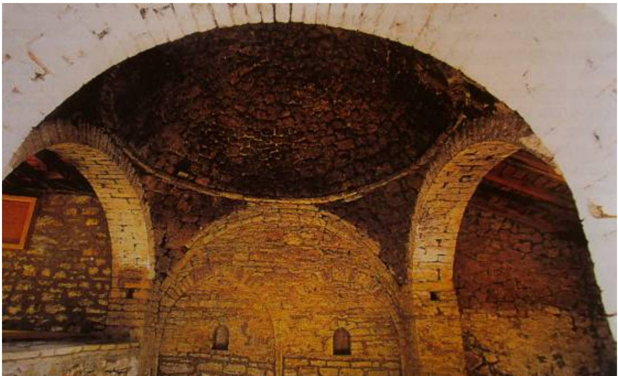
Εικ. 2.26. Άποψη της Γκούρας. Διακρίνονται οι αψιδωτές πλευρές της και η κατασκευή του θόλου. (φωτογραφία: Συρράκο. Πέτρα – Μνήμη – Φως, Τόμος 1)
