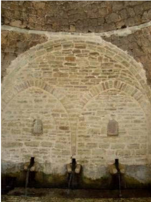
Εικ. 2.25. Μερική άποψη της Γκούρας: Η βρύση στο κέντρο του Συρράκου. Είναι ιδιαίτερα εντυπωσιακή η κατασκευή της. Η κάτοψη του χώρου είναι τετράγωνη. Η βόρεια πλευρά της (φωτογραφία) είναι τοίχος, στον οποίο διακρίνεται αψιδωτή κατασκευή. Οι υπόλοιπες τρεις πλευρές της είναι διαμπερείς, αψιδωτές κατασκευές. Στεγάζεται με θόλο, ο οποίος δημιουργεί έναν πλήρη κύκλο (σε κάτοψη) και στέγη με σχιστόπλακα (επάνω). Το υλικό κατασκευής του θόλου είναι ελαφρόπετρα. Η συγκεκριμένη κατασκευή της βρύσης εκτιμάται ότι πρέπει να προκύπτει και από την επιθυμία απόδοσης συμβολικής διάστασης στο χώρο, εφόσον απλούστερη κατασκευαστικά στέγαση θα αρκούσε, λειτουργικά (φωτογραφία: Προσωπικό αρχείο).
