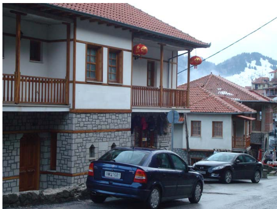
Εικ. 4.7. Η χρήση της πέτρας μόνο στο ισόγειο δημιουργεί τον χαρακτηριστικό διαχωρισμό του κτιρίου σε δύο «ζώνες», του ισογείου και του με λευκό επίχρισμα ορόφου. Χαρακτηριστικές και οι εμφανείς ξυλοδεσιές, οι οποίες επειδή δεν προκύπτουν, πια, ως κατασκευαστικό στοιχείο τοποθετούνται διακοσμητικά και κατά βούληση. Επιμέρους στοιχεία (τρόπος κατασκευής πέτρας, ανοίγματα ισογείου και κινέζικα διακοσμητικά) αποτελούν χαρακτηριστικά της προσωπικής πρωτοβουλίας του ιδιοκτήτη. Ο σύγχρονος τρόπος κατασκευής αναιρεί τη διαφοροποίηση του υλικού (ίδια, κατασκευαστικά, η τοιχοποιία ισογείου και ορόφου) (φωτογραφία: Προσωπικό αρχείο).
