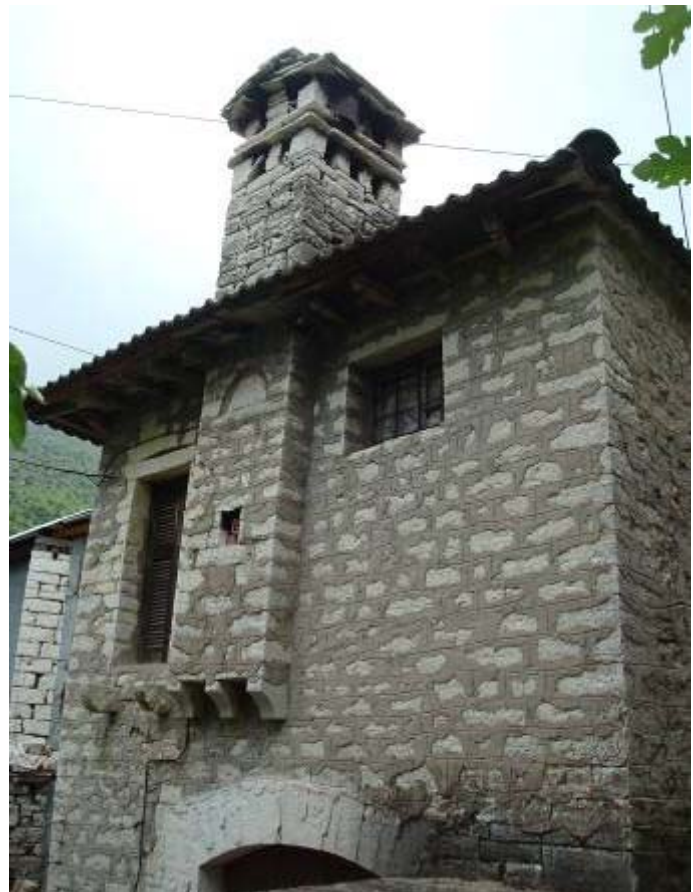
Εικ. 2.24. Τζάκι, εξωτερικά. Φαίνεται η χαρακτηριστική κατασκευή της απόληξης του στο κάτω τμήμα του και το μικρό άνοιγμα, λίγο ψηλότερα. Στο συγκεκριμένο διακρίνεται και διακοσμητική τοποθέτηση λίθινου ημικυκλικού τόξου, κάτω από το γείσο της στέγης. Στο κάτω τμήμα του μεγάλου παραθύρου διακρίνονται τα πέτρινα φουρούσια (οι ξύλινες σανίδες δεν έχουν αντικατασταθεί, σε όλο τον οικισμό). (φωτογραφία: Προσωπικό αρχείο)
