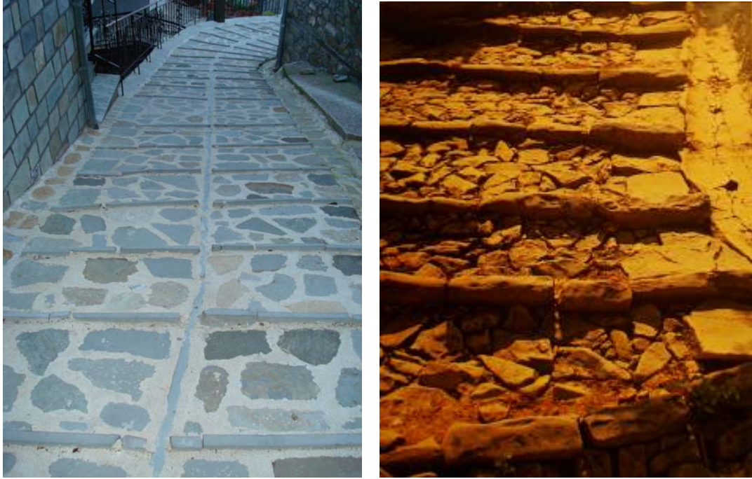
Εικ. 4.10. (αριστερά): Σύγχρονο μονοπάτι. Ο σύγχρονος τρόπος κατασκευής των καλντεριμιών ακολουθεί τον τρόπο κατασκευής δαπέδου πλατείας, χωρίς να υπάρχει πρόβλεψη για την προστασία από την ολισθηρότητα (χιόνι και βροχή) και τη διοχέτευση του νερού (λούικια). Επιπλέον, ως αποτέλεσμα κακής απομίμησης της τοπικής παράδοσης δημιουργούνται οριζόντιες λωρίδες με κομμάτια μαρμάρου, οι οποίες δεν έχουν καμία λειτουργική χρησιμότητα (οι αντίστοιχες, στο παραδοσιακό καλντερίμι, ήταν τοποθετημένες σε συγκεκριμένες αποστάσεις και με ορισμένο τρόπο κατασκευής ώστε να συγκρατούν ανθρώπους και ζώα στην κίνησή τους σε κλίση και ολισθηρό έδαφος). Οι αποστάσεις των σύγχρονων αυτών λωρίδων είναι μάλλον τυχαίες, στοιχείο που αναδεικνύεται όταν κανείς περπατήσει, ειδικά σε ορισμένα μονοπάτια (φωτογραφία: Προσωπικό αρχείο) (δεξιά): Παραδοσιακή κατασκευή μονοπατιού (φωτογραφία: Χαρίσης, 1995).
