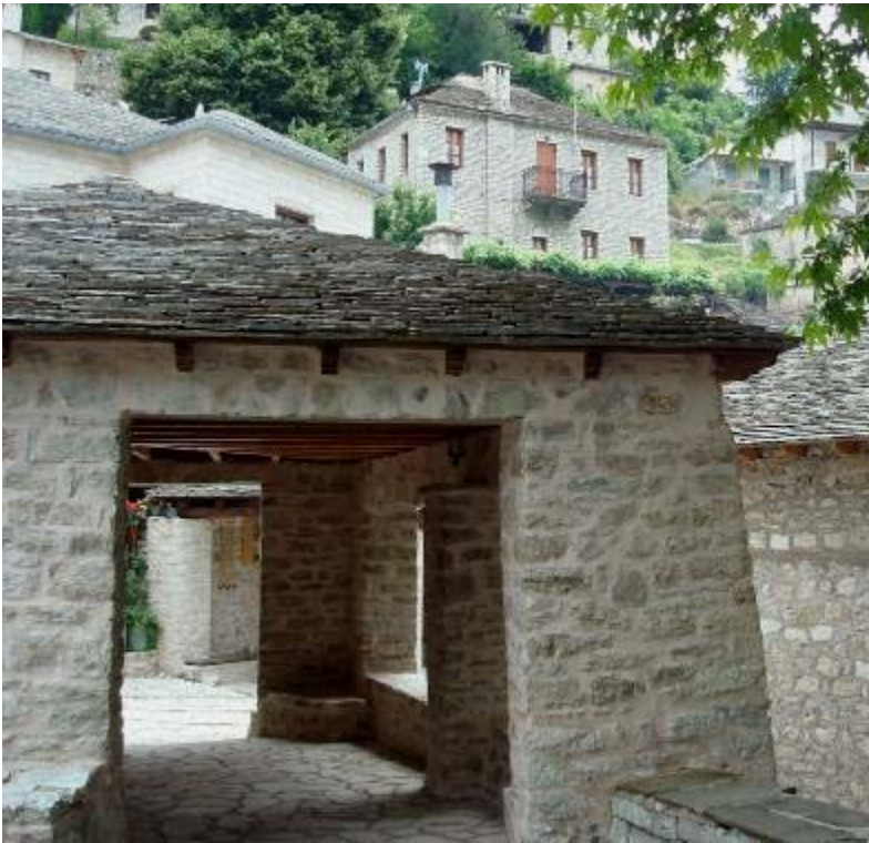
Εικ. 2.23. Το χαγιάτι, στο επάνω τμήμα της πλατείας, δίπλα στην εκκλησία του Αγ. Νικολάου. Εσωτερικά, αριστερά, υπάρχει πέτρινο πεζούλι (φωτογραφία: Προσωπικό αρχείο).
