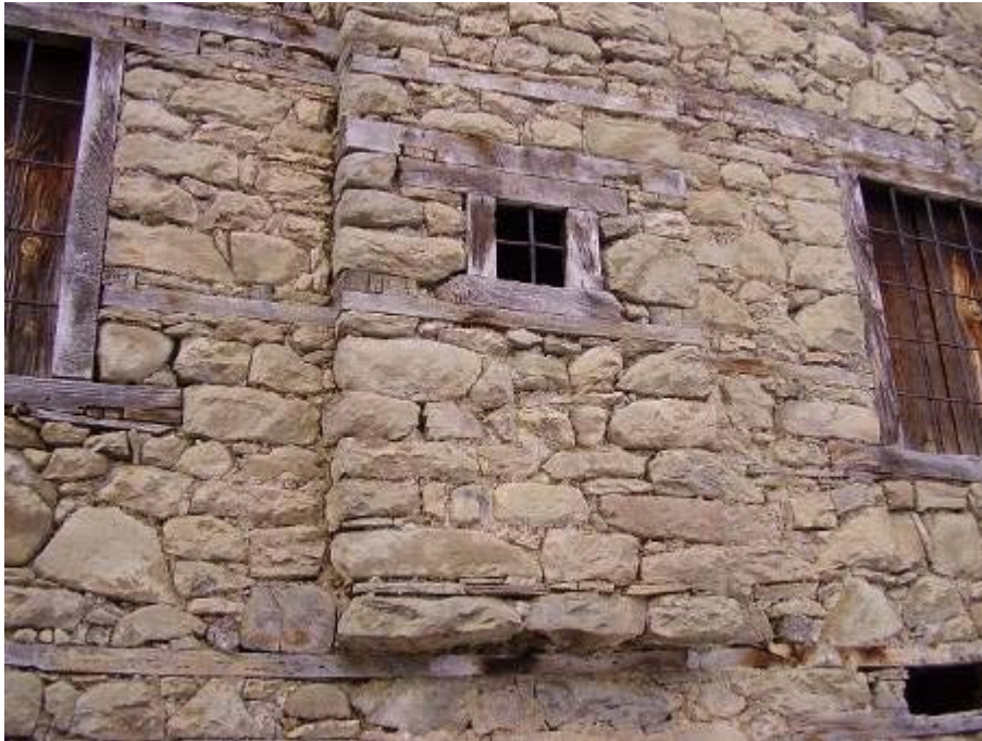
Εικ. 2.7. Λεπτομέρεια κατασκευής της καμινάδας του τζακιού, η οποία προεξέχει στην όψη. Διακρίνεται ο χαρακτηριστικός φεγγίτης και η απόληξη του κάτω τμήματος που κατασκευάζεται διαφορετικά από την αντίστοιχη, στο Συρράκο (φωτογραφία: Προσωπικό αρχείο).
